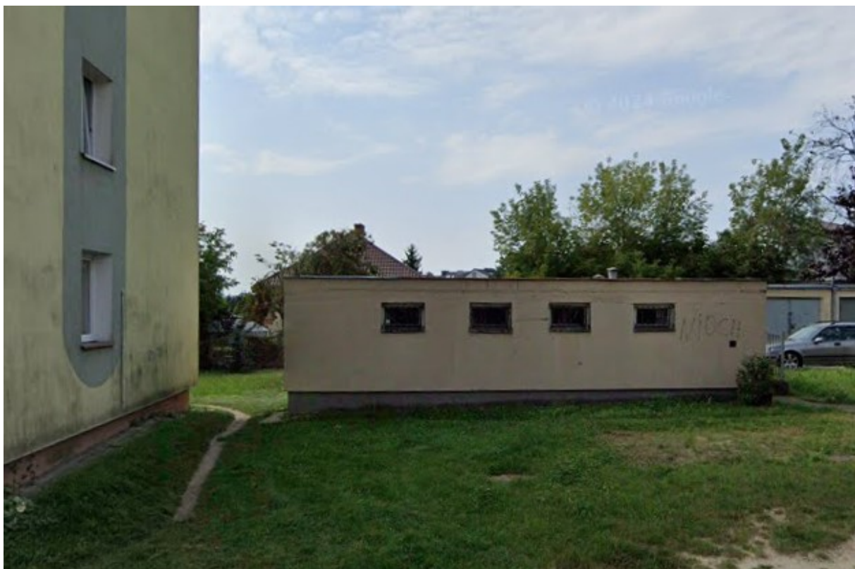
Widok budynku od strony wschodniej
