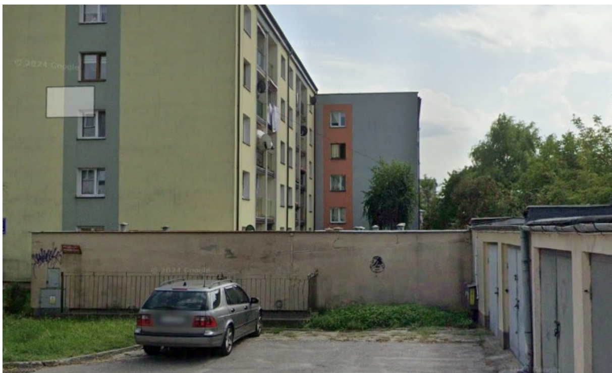
Strona północna budynku
